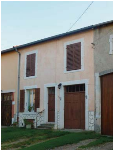
9 rue de l'Eglise, façade habitation et grange
