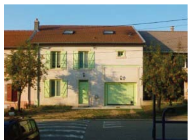
12 rue de l'Eglise, façade habitation et grange
