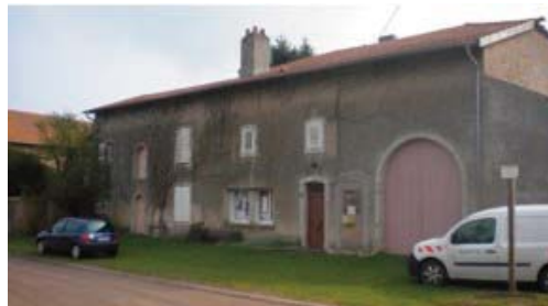
.. rue du Haut-Bourg, façade habitation et grange
