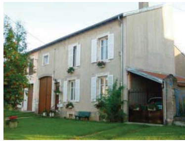
11 rue de l'Eglise, façade habitation et grange
