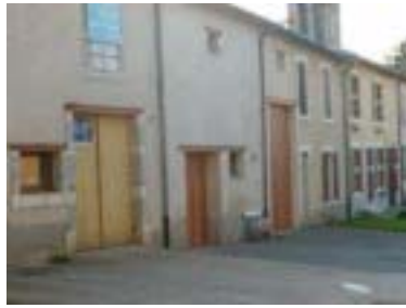
5 rue de l'Eglise, façade habitation et l'ensemble des ouvertures
