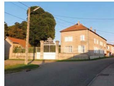
5 place du Château, façade habitation, toiture quatre pans et clôture
