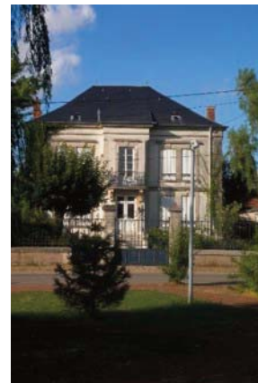
1 rue de Lunéville, façade avant, clôture avec portail et toiture quatre pans
