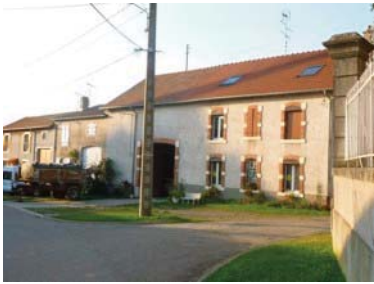
2 rue de l'Eglise, façade habitation et porte de grange
