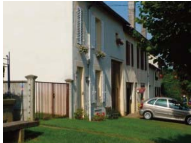
15 rue de l'Eglise, façade habitation et grange
