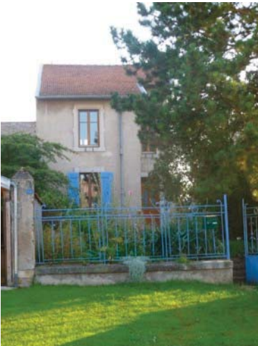
13 rue de l'Eglise, façade habitation et clôture
