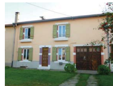
7 rue de l'Eglise, façade habitation et la porte de grange
