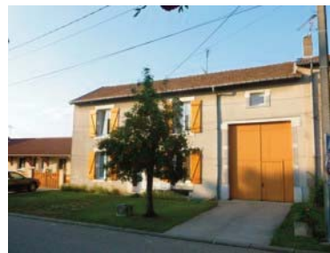
6 rue de l'Eglise, façade habitation et de la grange
