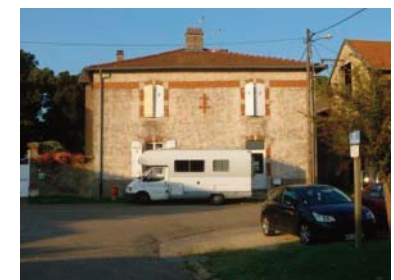
5 place du Château, façade habitation, toiture quatre pans et clôture
